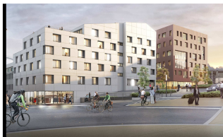
ILOT MAGENTA - DUVAL Commerces, bureaux et logements (5560 m 2 ) Démarrage travaux : Septembre 2021
