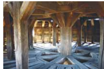
La charpente de la tour maîtresse du château de Laval
