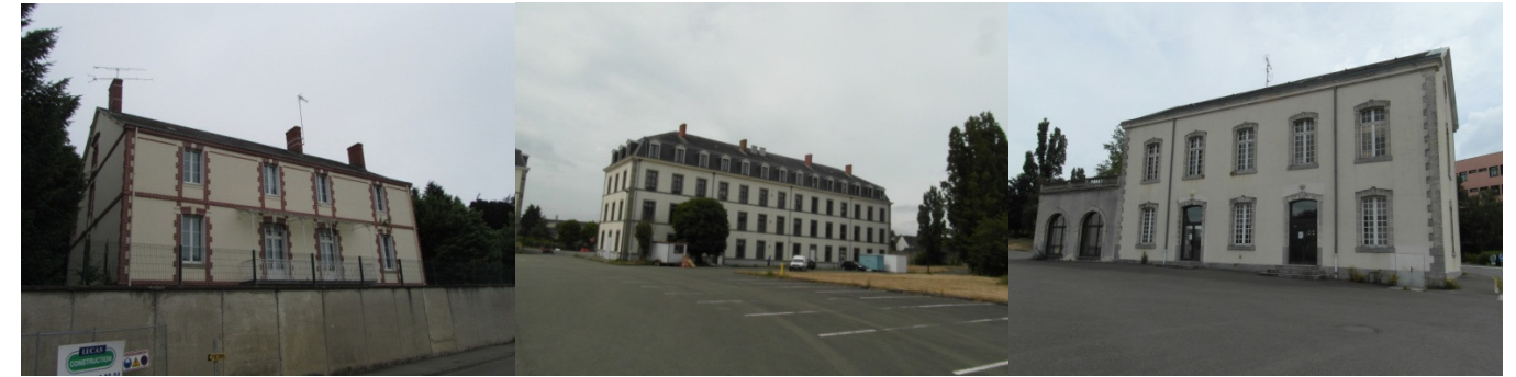
Figure 38 : la partie historique de la caserne
