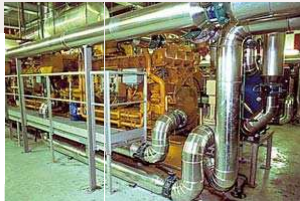
Géothermie « basse énergie » La Courneuve (1993)
