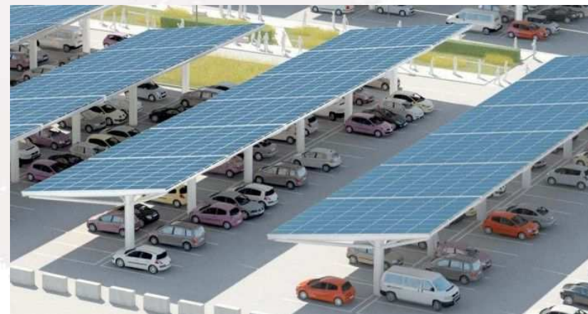
Exemple de panneaux photovoltaïques intégrés en ombrières de parking
