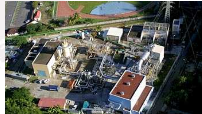
Géothermie « haute énergie » Centrale de Bouillante (Guadeloupe)
