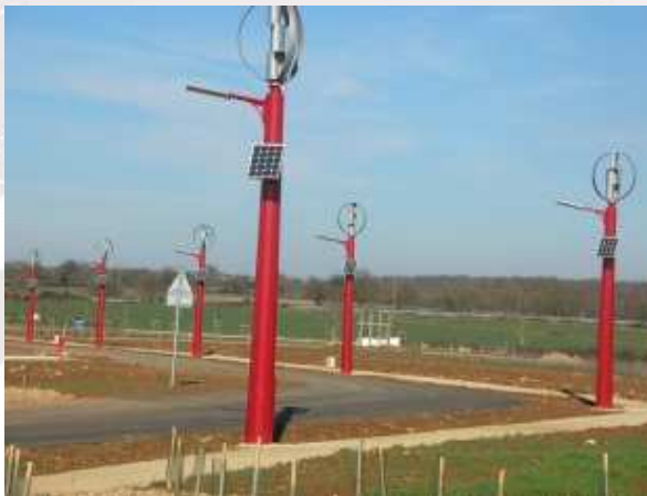
Exemple de mâts d'éclairage public intégrant éoliennes et panneaux photovoltaïques
