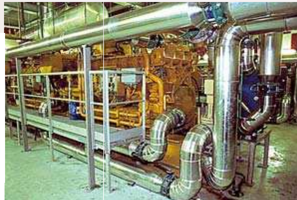
Géothermie « basse énergie » La Courneuve (1993)
