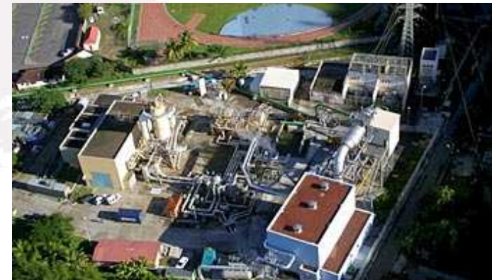
Géothermie « haute énergie » Centrale de Bouillante (Guadeloupe)
