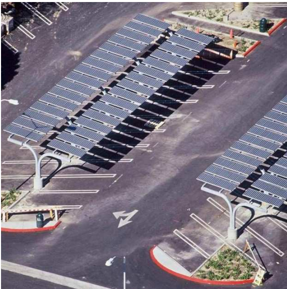
Exemple de panneaux solaires photovoltaïques intégrés en ombrière dessus un parking
