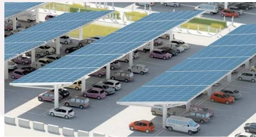
Exemple de panneaux photovoltaïques intégrés en ombrières de parking
