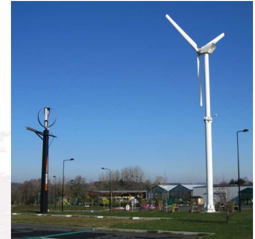
Deux types d'éoliennes à axe horizontal et vertical - Combourg (35)
