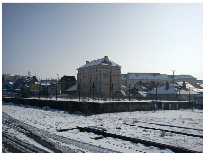
Photo 6 : vue sur le Quai Haut sur le Lot n°030
