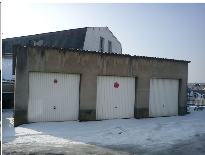
Photo 16 : vue sur les garages pour véhicules légers pour particuliers sur le Lot n°014
