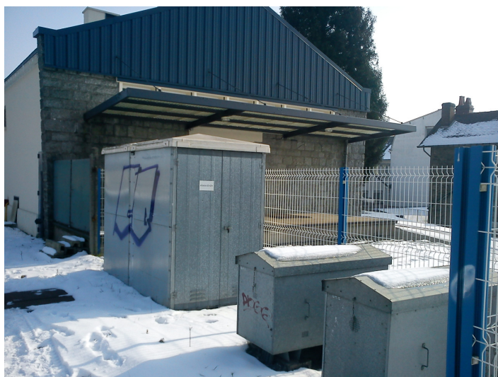
Photo 17 : vue sur le poste transformateur sur le Lot n°014
