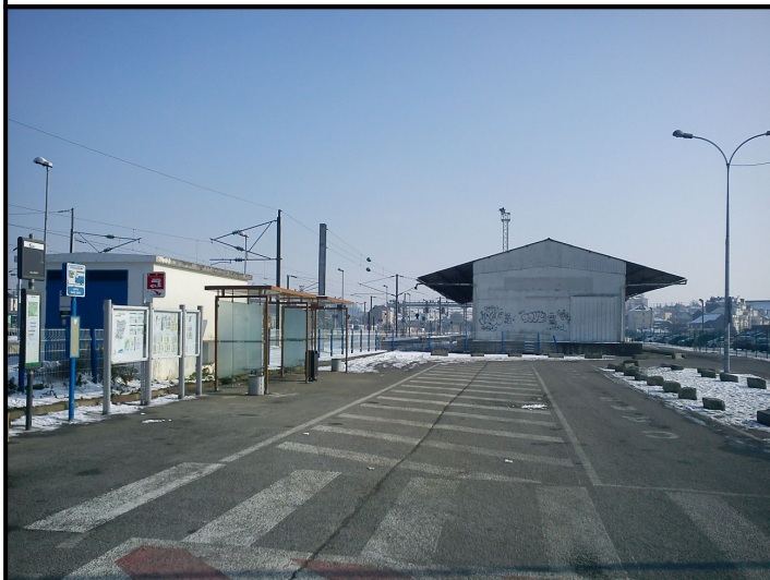
Photo 1 : vue sur les Lots n°008 (parking) et n°007 (Ancienne Halle SERNAM)
