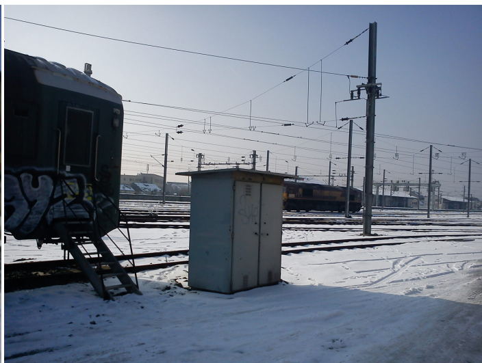
Photo 10 : vue sur le poste transformateur sur le Lot n°023
