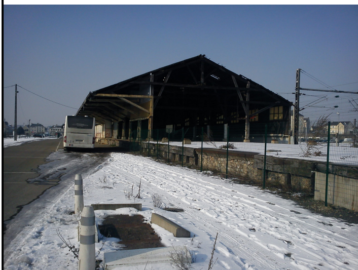
Photo 5 : vue sur la deuxième ancienne Halle SERNAM sur le Lot n°006
