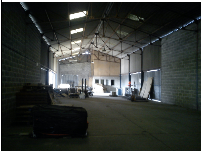
Photo 3 : vue l'intérieur de l'ancienne Halle SERNAM
