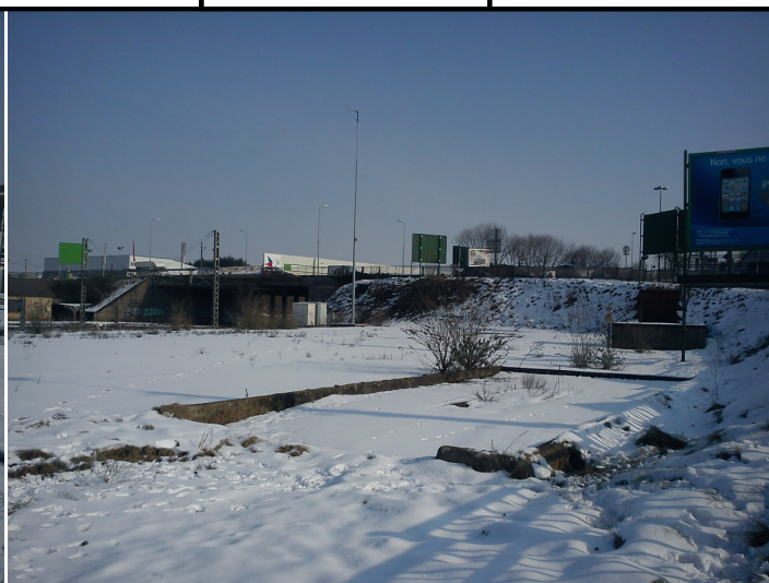
Photo 8 : vue sur la partie Est du Lot n°030
