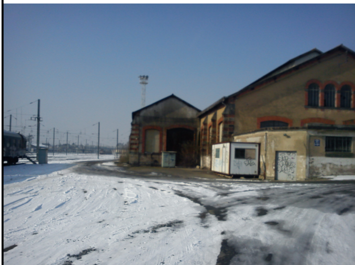
Photo 9 : vue le Lot n°026 (chemin d'accès)
