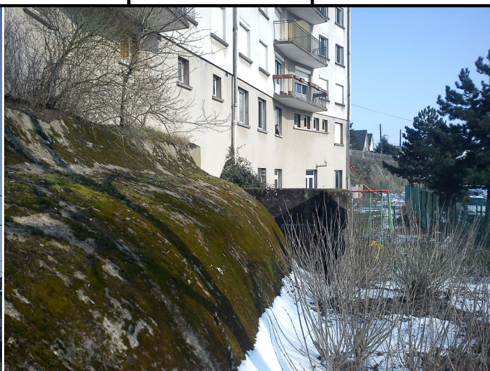
Photo 14 : vue sur les Lots n°028 et n°010
