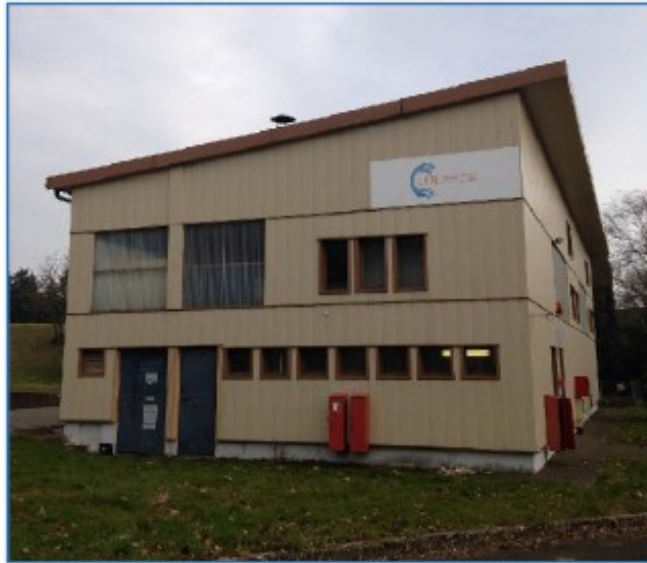
Photo de la chaufferie du réseau Ferrière avant rénovation.
