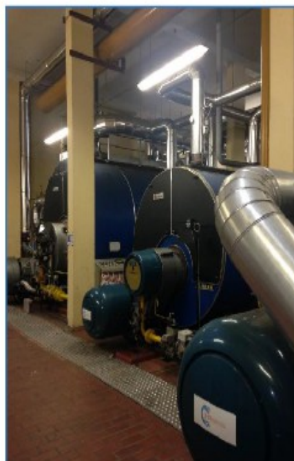
Photo des moyens de production de la centrale thermique Saint Nicolas.
