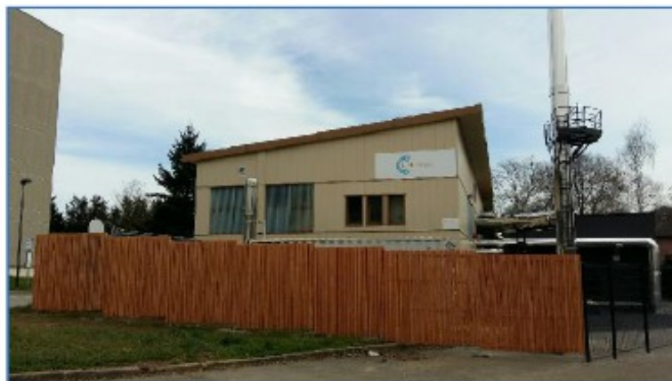
Photo de la chaufferie Ferrière après rénovation, avec à droite la sous-station d'échange
