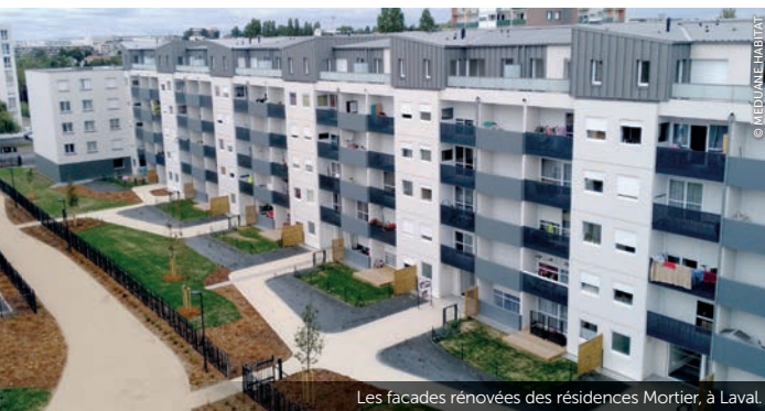
Les façades rénovées des résidences Mortier, à Laval.
