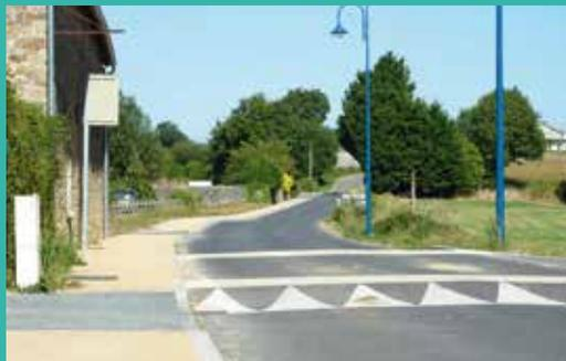
Afin de réduire la vitesse des véhicules, sécuriser les carrefours et faciliter les déplacements des piétons, la commune vient de réaménager la rue René Girault et la rue du Casino. Ont été réalisés des trottoirs accessibles aux personnes à mobilité réduite et trois plateaux surélevés où la vitesse est limitée à 30 km/h. Les travaux, achevés fin mai, seront complétés par des aménagements paysagers. Coût total, 292 730 € TTC, avec une aide de Laval Agglomération de 50 000 €.
