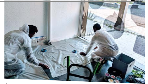
À la Maison des projets Saint-Nicolas, un chantier Argent de poche a été mené en avril 2023.
