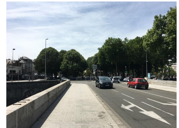
Vue depuis le pont A. Briand
