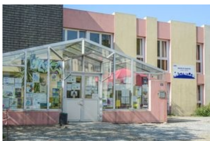
Maison de Quartier - Laval-Nord
