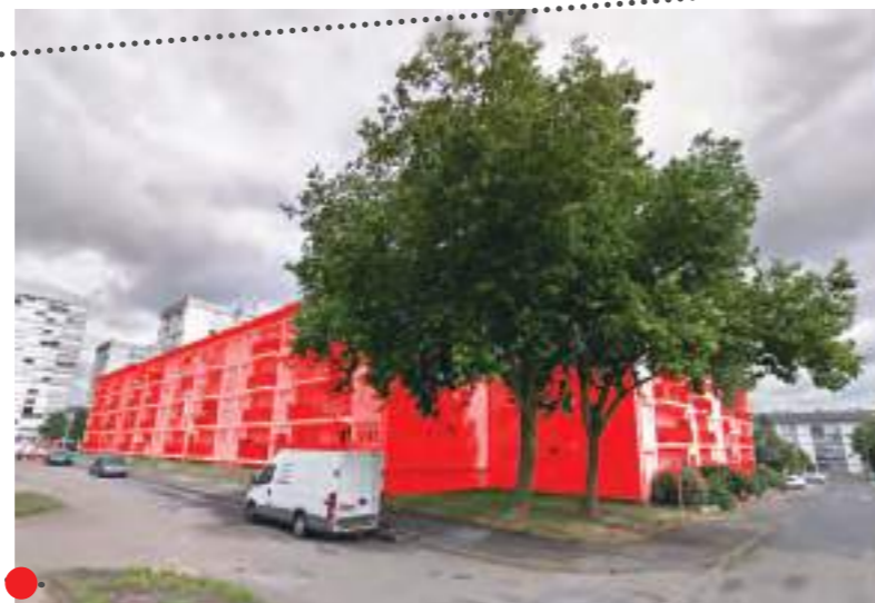
Démolition des barres U et V afin de diversifier le quartier par de nouveaux programmes de logements et pour clarifier la trame urbaine du quartier.
