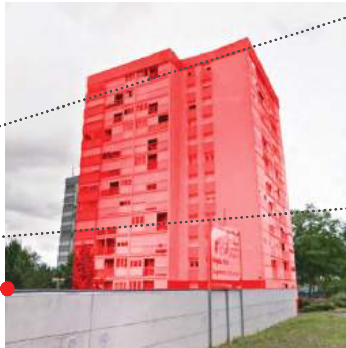
Démolition de la tour TC pour dédensifier le secteur, permettre la création de nouveaux aménagements au sol, permettre la création de nouveaux programmes, changer l'image du quartier.
