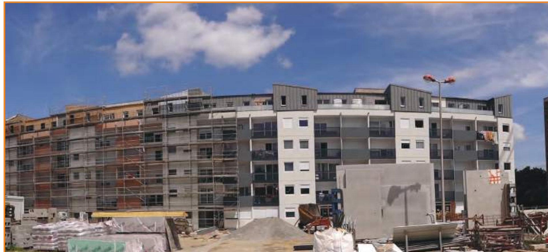
Photo du chantier en cours
