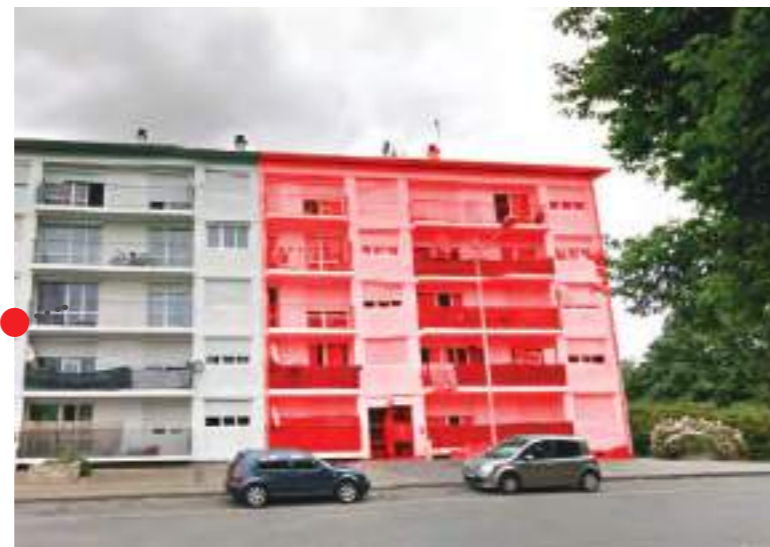
Démolition d'une cage d'escalier de la barre L afin de permettre le passage d'une nouvelle voie et de désenclaver le quartier.
