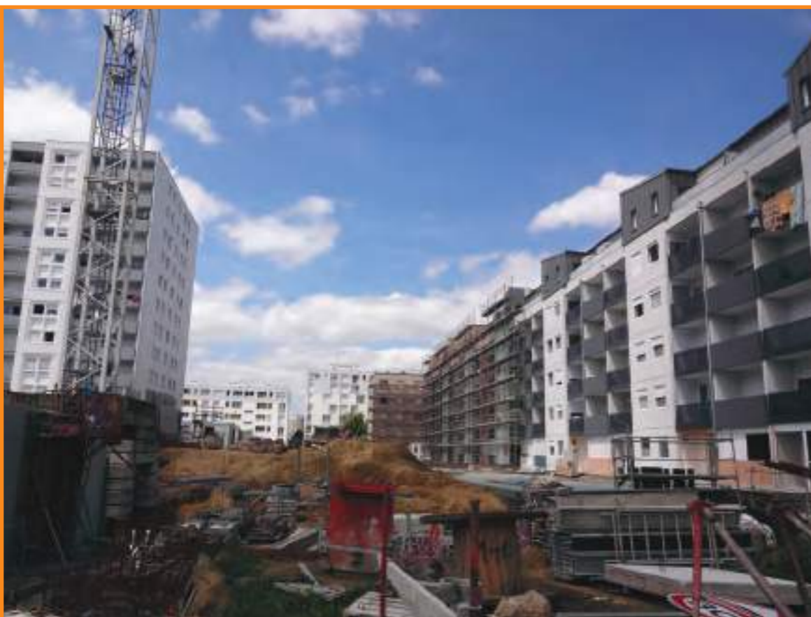
Photo du chantier en cours
