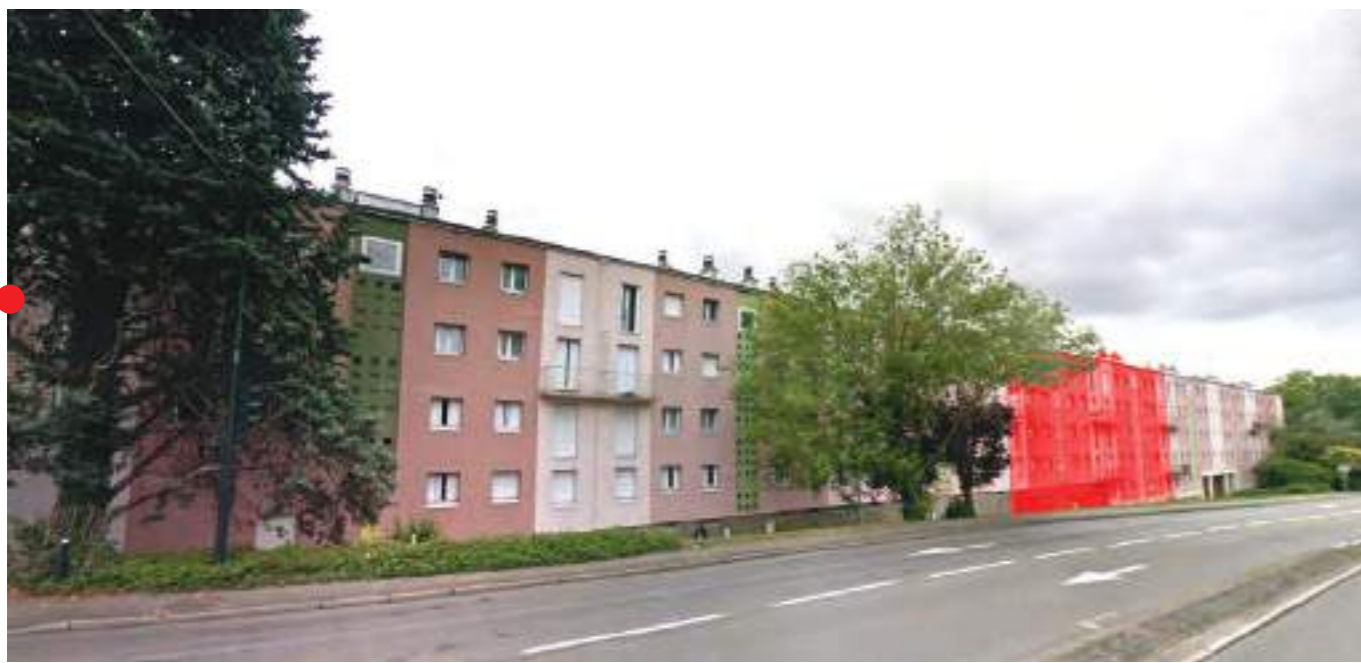
Démolition de 2 cages d'escalier afin de désenclaver le quartier et améliorer son image
