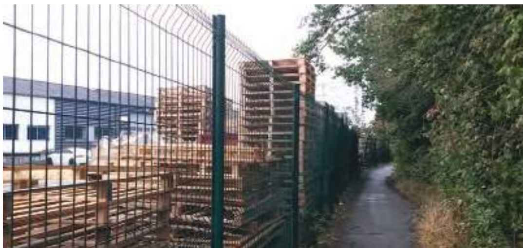
1. Chemin très peu qualitatif et donnant un sentiment d'insécurité emprunté par les habitants du quartier Kellermann afin de rejoindre rapidement la zone d'activité des Bozées et ses commerces.
