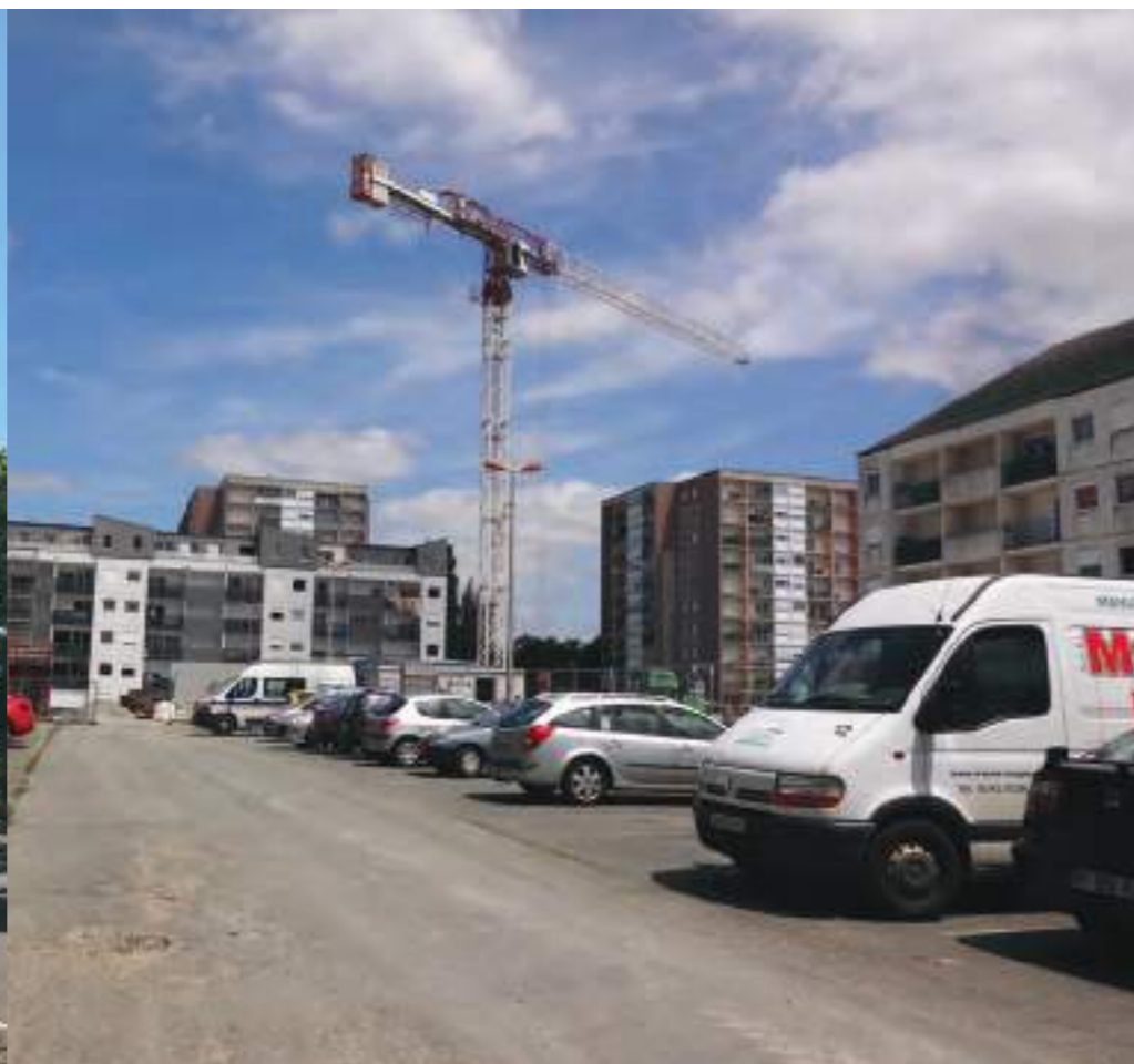
Patrimoine Méduane Habitat sur le secteur Mortier en phase de réhabilitation et de résidentialisation.
