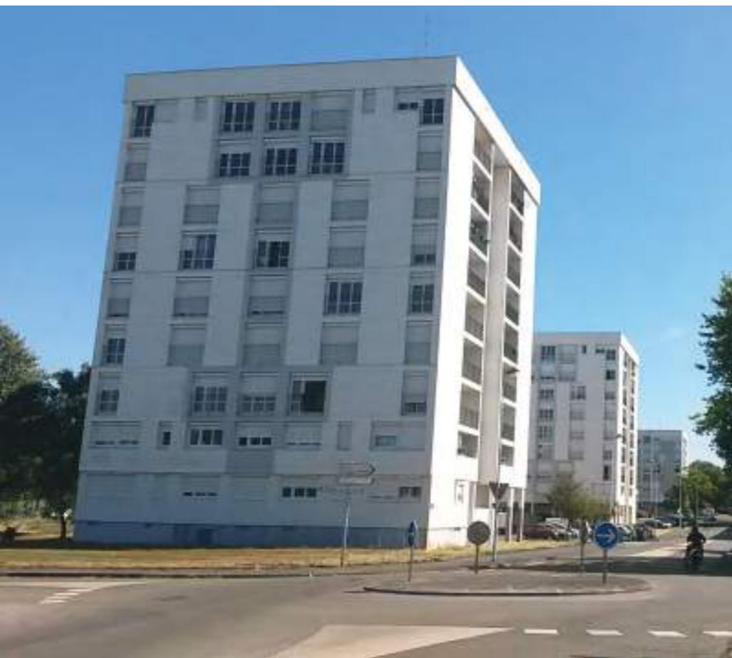
Patrimoine Mayenne Habitat sur le secteur Kellermann (bâtiments ABC prévus en réhabilitation et résidentialisation dès 2019)
