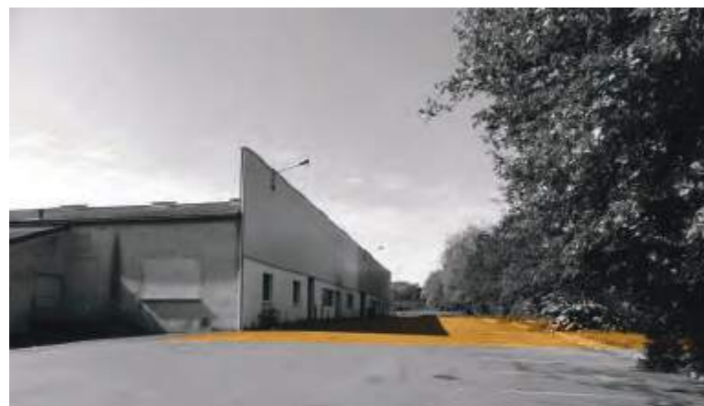
Aménagement d'un parvis au Palindrome vers le quartier
