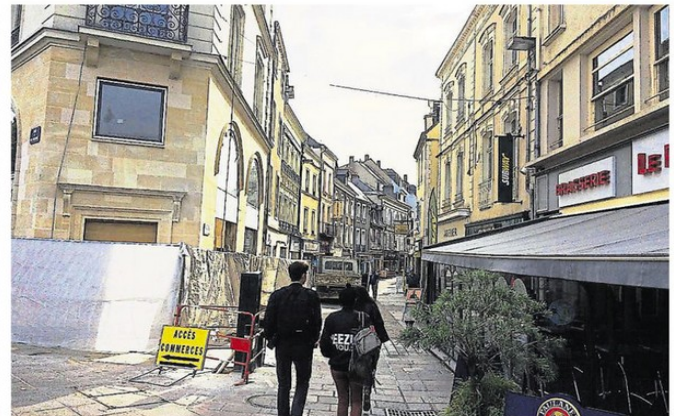
Rue du Val-de-Mayenne. Aujourd'hui piétonne (et en travaux), la rue pavée s'ouvre actuellement sur les travaux du Crédit Agricole, à gauche, et sur le café du Rond-Point, à droite.
