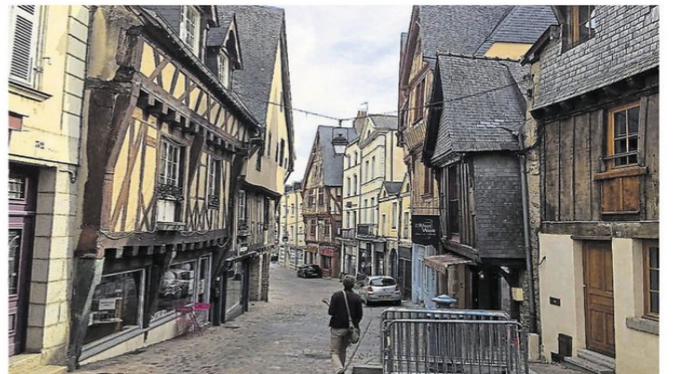
Grande-Rue. À gauche, les locaux sont occupés par Lecture en tête et à droite, le bar l'AfterWork s'est installé.
