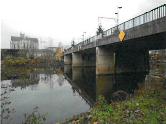
Pont de Changé-Lès-Laval
