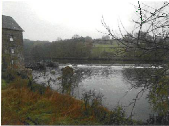
Barrage de Belle Poule
