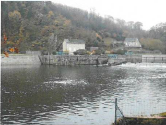
Ecluse du barrage de Bonne
