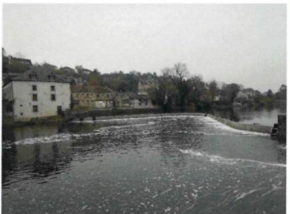
Barrage de Bootz
