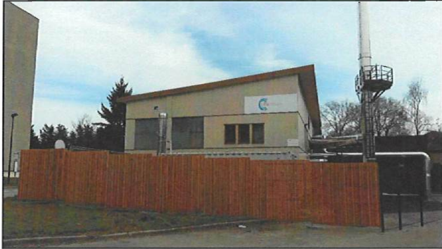
Photographie de la chaufferie Ferrié après rénovation, avec à droite la sous-station d'échange
