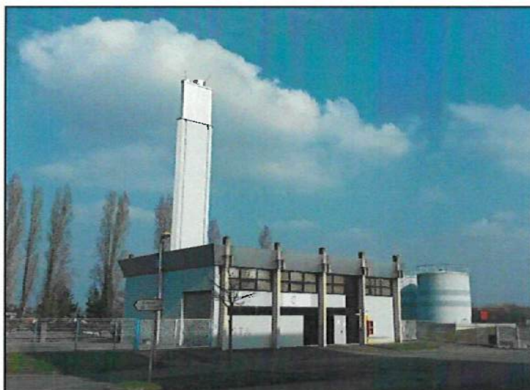
Photographie de la chaufferie Saint-Nicolas
